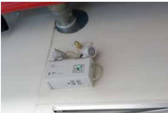
ไฟฟ้าสองสว่างฉุกเฉิน
