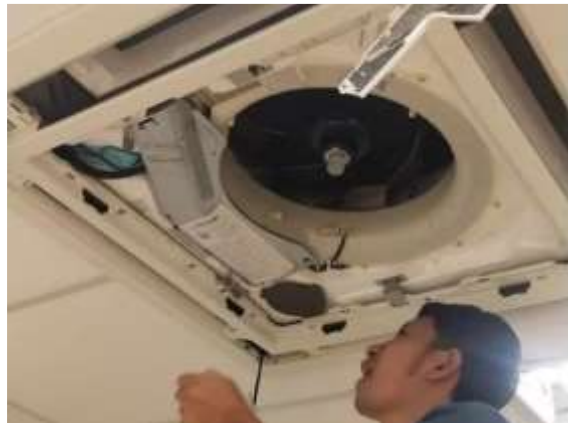
ภาพที่ 2-23 เจ้าหน้าที่ทำความสะอาดเครื่องปรับอากาศ
