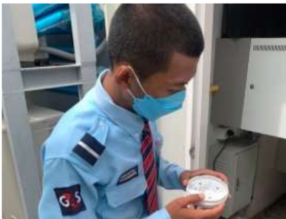
ตรวจสอบเครื่องตรวจจับควัน
