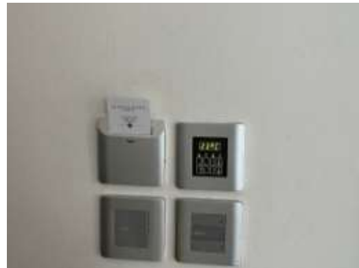
ระบบ KEY CARD ควบคุมไฟฟ้าในห้องพัก
