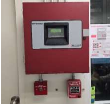
Telephone Jack และ Manual Station
