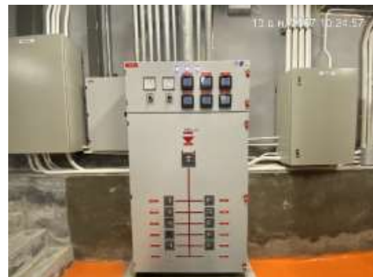
Main Distribution Board : MDB และ Circuit Breaker : CB
