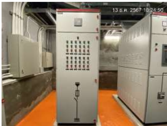
Main Distribution Board : MDB และ Circuit Breaker : CB
